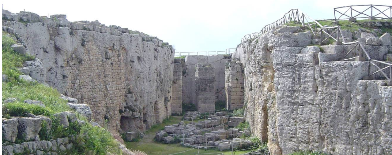
Fig. 5 – Castello Eurialo, terzo fossato con i tre piloni di sostegno del ponte levatoio (foto autore).
